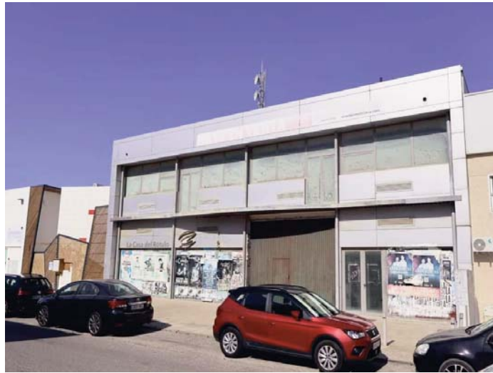
Nueva instalación, junto al centro Box. VIVA
