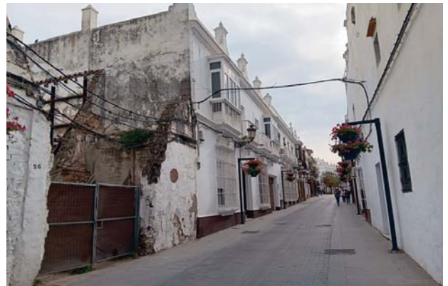
Los solares y fincas en ruinas, alternativas a VIVA
